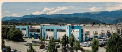
Sede centrale e produttiva di Keyline Spa a Conegliano (TV)
